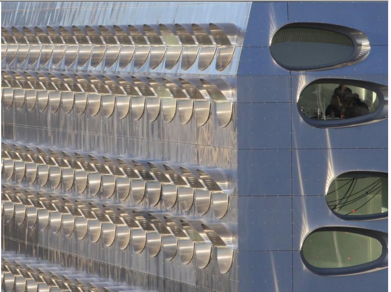
Les ouvertures couvrent avec fluidité l'ensemble de l'enveloppe ©JPPorcher
